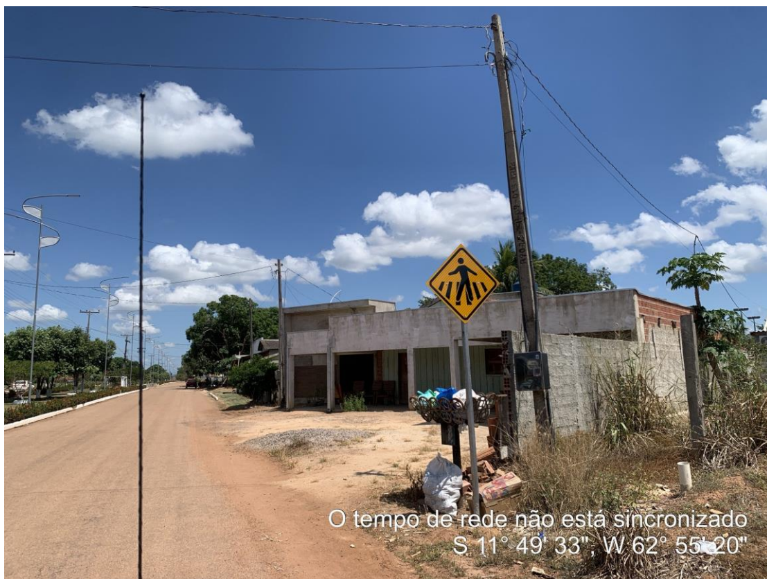
Sinalização vertical implantada – Município de Seringueiras/RO
