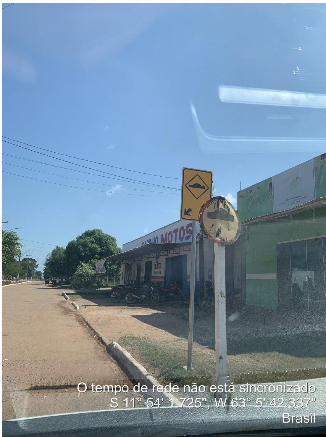
Sinalização vertical implantada – Município de Seringueiras/RO
