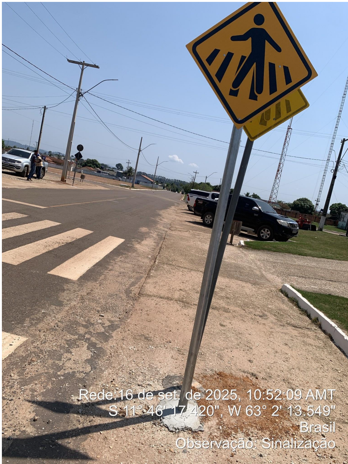
Sinalização vertical implantada – Município de Seringueiras/RO
