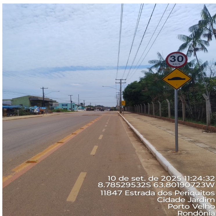
Imagem 11 e 12: Sinalização Pare completa (vertical e horizontal)
