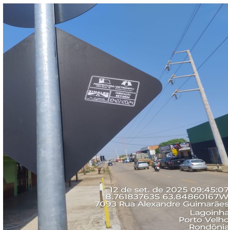
Imagens 07 e 08: Implantação de Faixas de Travessia de Pedestres com Placas de Advertência
