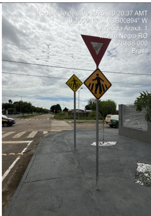
Foto 12: altura livre da placa dupla está inferior ao especificado no projeto aprovado. Placas em duplicidade.
