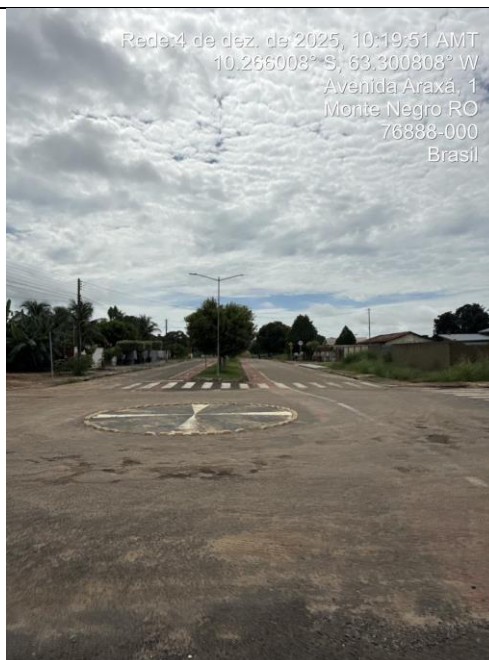
Foto 34: sinalização horizontal em conformidade com o projeto aprovado.
