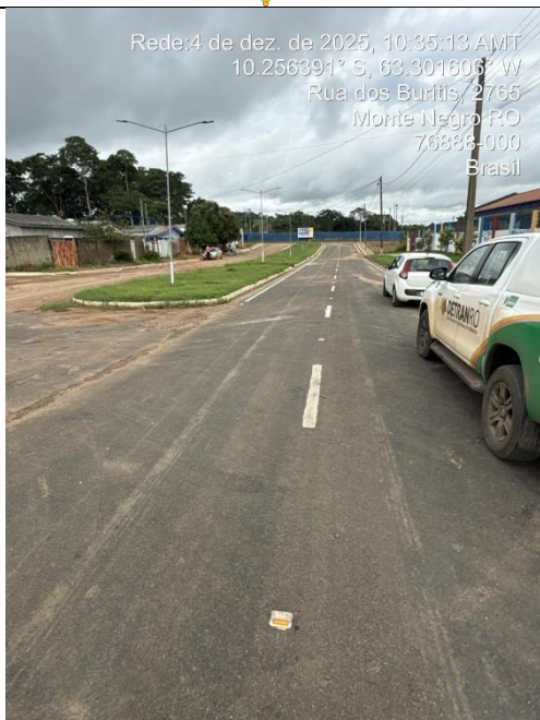
Foto 19: sinalização horizontal em conformidade com o projeto aprovado.
