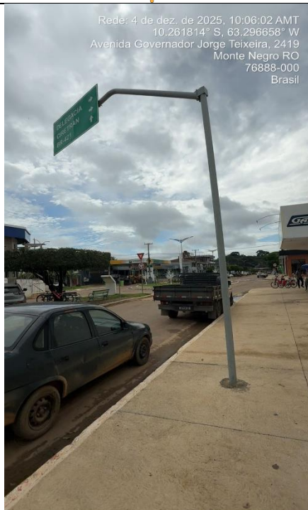
Foto 7: braço projetado encontra-se seriamente empenado
