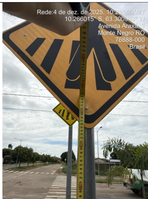
Foto 18: placa dupla apresenta altura livre de 1,85 m, abaixo do especificado.
