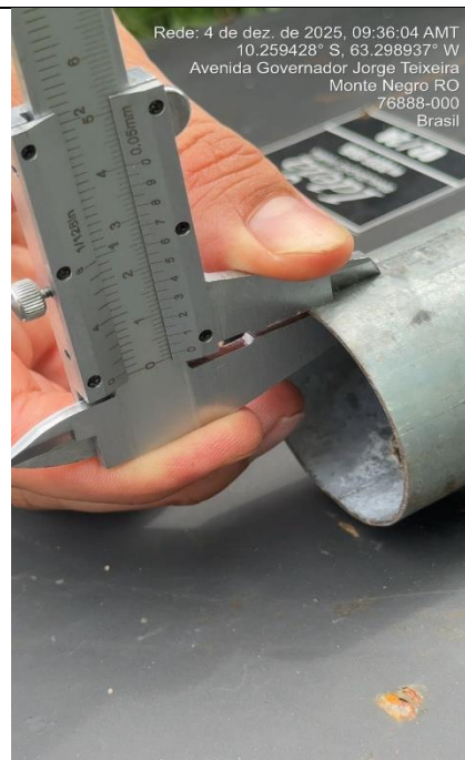
Foto 4: Chapa do suporte com espessura inferior ao especificado
