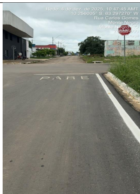
Foto 16: Sinalização R-1 e Legenda pare em conformidade com o projeto aprovado.
