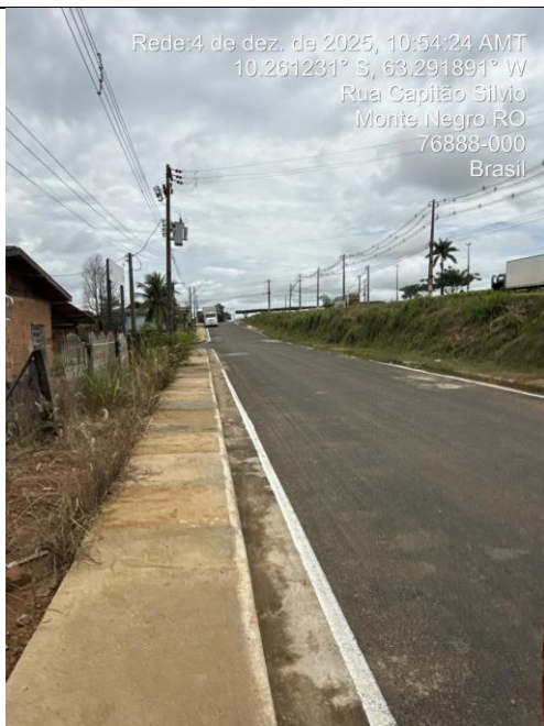
Foto 25: sinalização horizontal em conformidade com o projeto aprovado.
