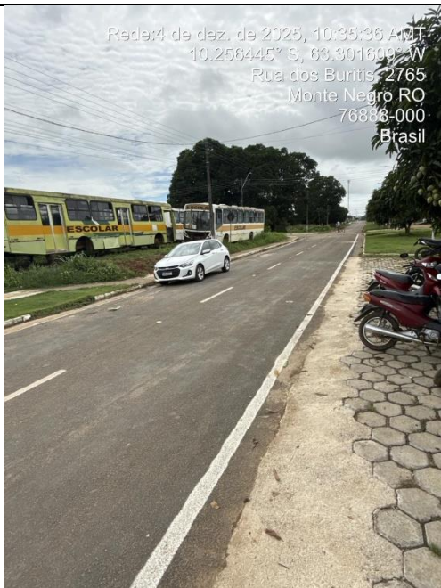
Foto 21: sinalização horizontal em conformidade com o projeto aprovado.
