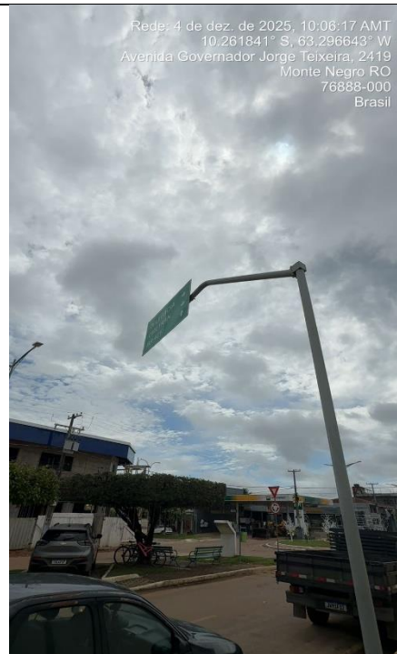
Foto 8: braço projetado encontra-se seriamente empenado.
