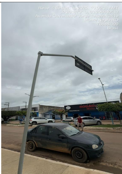
Foto 9: braço projetado encontra-se seriamente empenado.
