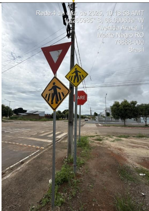
Foto 11: altura livre da placa dupla está inferior ao especificado no projeto aprovado. Placas em duplicidade.
