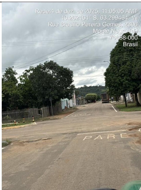
Foto 28: sinalização horizontal em conformidade com o projeto aprovado.
