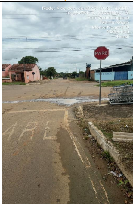
Foto 23: Sinalização R-1 e Legenda pare em conformidade com o projeto aprovado.
