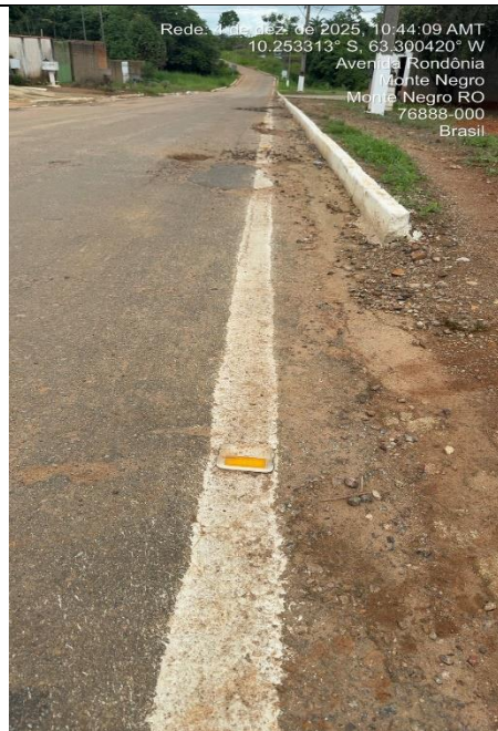
Foto 24: tachas foram devidamente aplicadas nos locais determinados nos projetos encaminhados.
