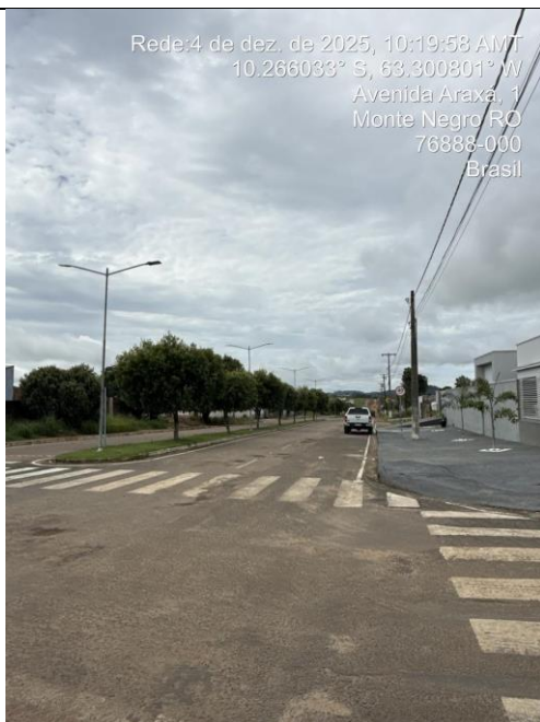
Foto 33: sinalização horizontal em conformidade com o projeto aprovado.
