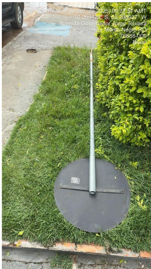
Foto 1 : sinalização vertical (placa e suporte) foi retirada do ponto de implantação e deixada no chão.
