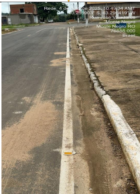
Foto 31: sinalização horizontal em conformidade com o projeto aprovado.
