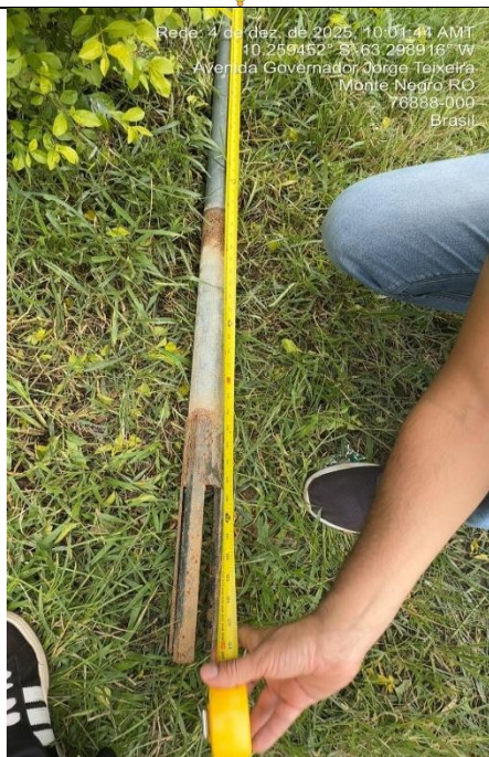
Foto 3: Suporte/tubo de aço – altura inferior ao especificado
