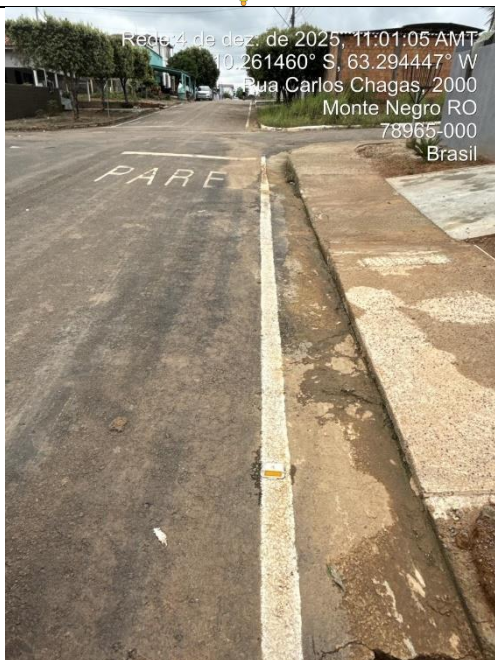
Foto 27: Não foi localizada a sinalização R-1 no cruzamento da Rua Carlos Chagas com Rua Ronilson Medeiros.
