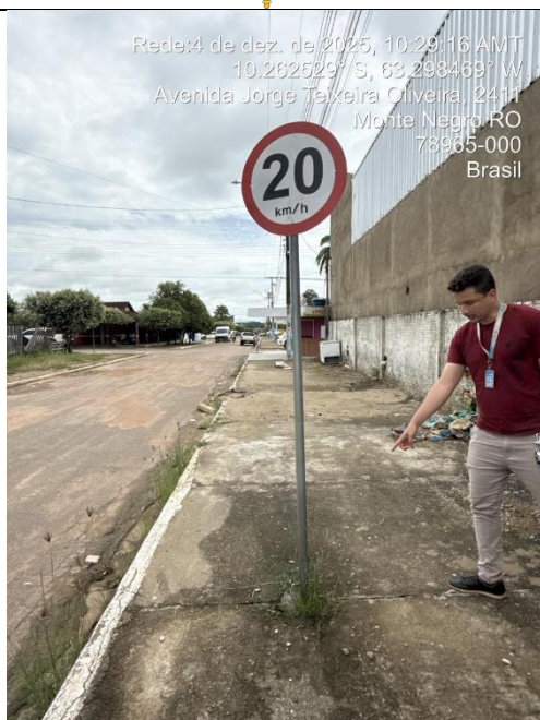
Foto 15: a sinalização vertical permanece com o suporte mal fixado.
