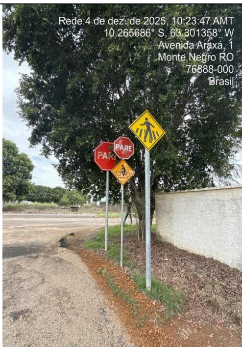
Foto 13: altura livre da placa dupla está inferior ao especificado no projeto aprovado. Placas em duplicidade.
