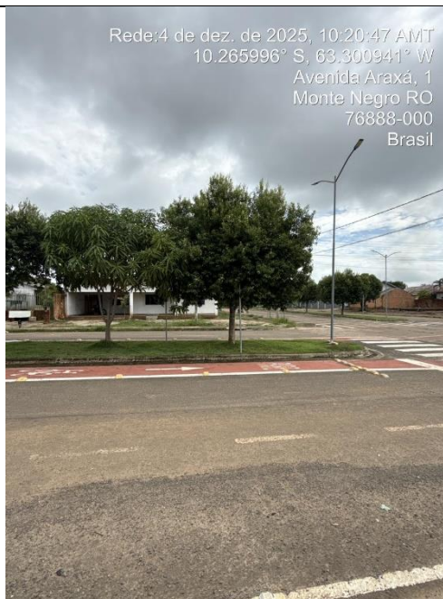
Foto 32: Ciclofaixa implantada conforme projeto aprovado.
