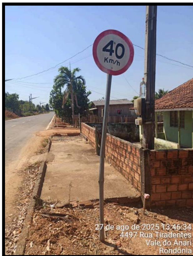
Imagem 02: película desgastada e suporte danificado
