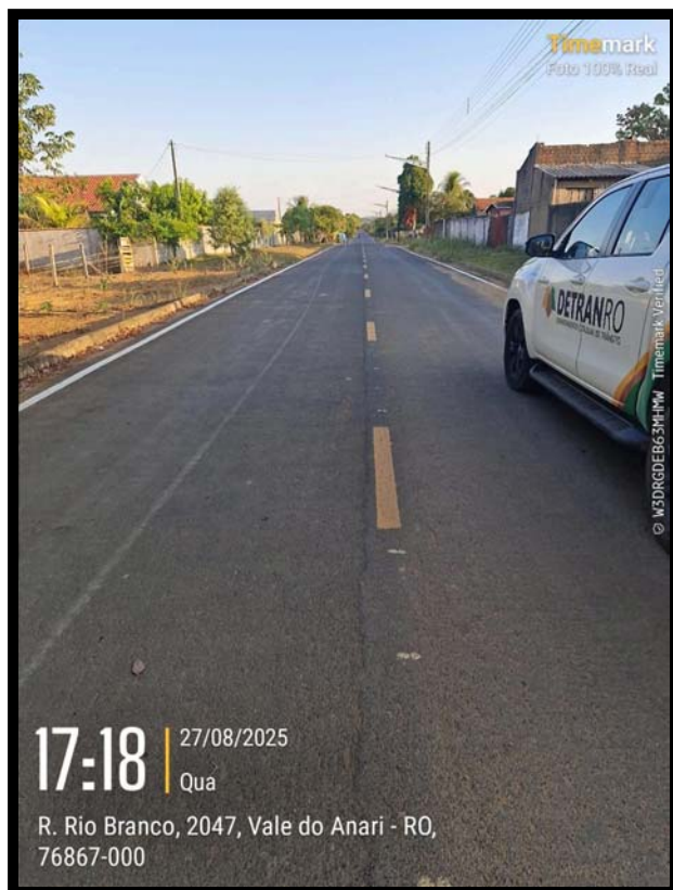
Imagem 12: Sinalização horizontal satisfatória
