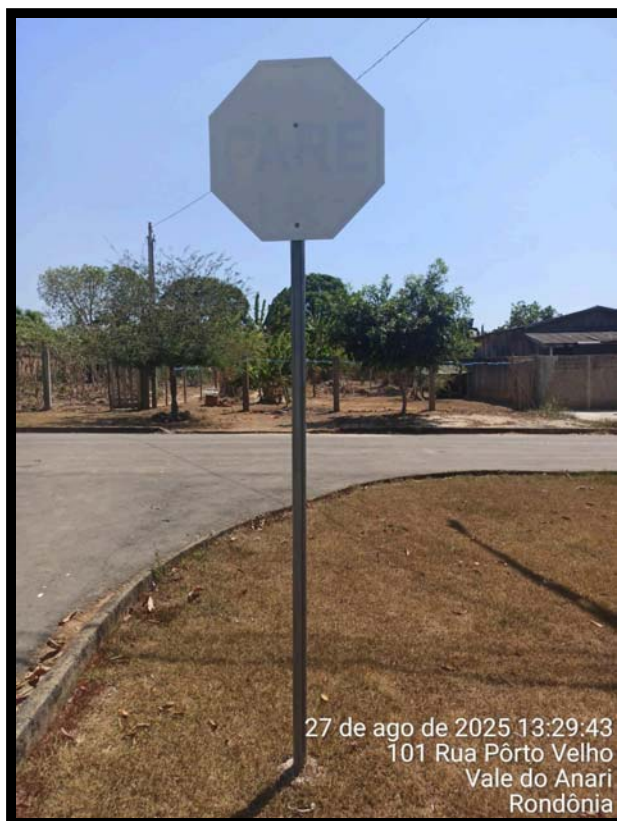
Imagem 01: Película desgastada precocemente
