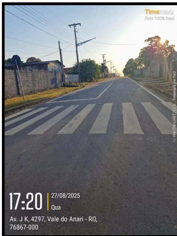
Imagem 13: Sinalização horizontal satisfatória
