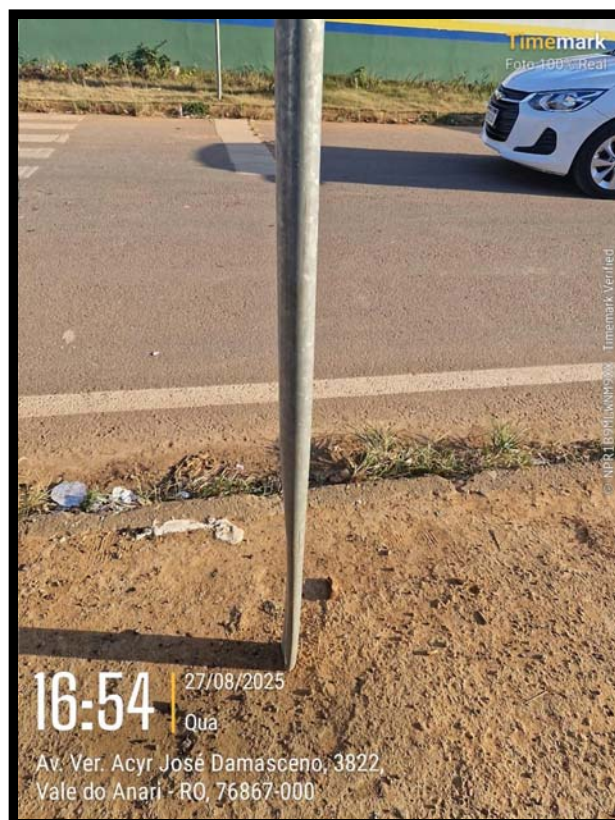
Imagem 02: película desgastada e suporte danificado
