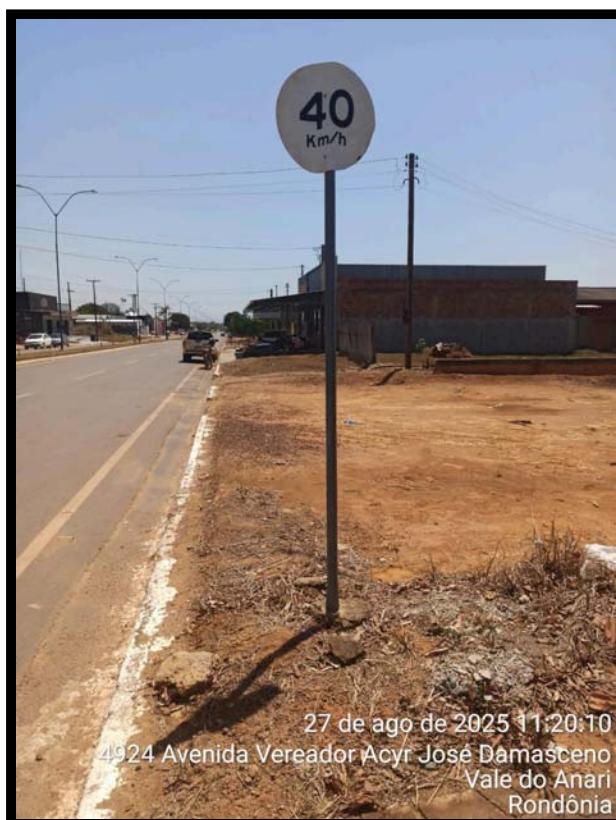
Imagem 01: Película desgastada precocemente
