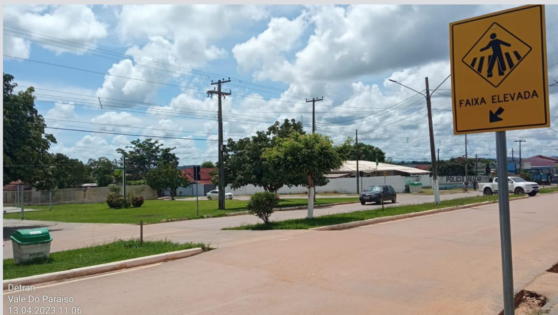
faixa elevada incompleta
