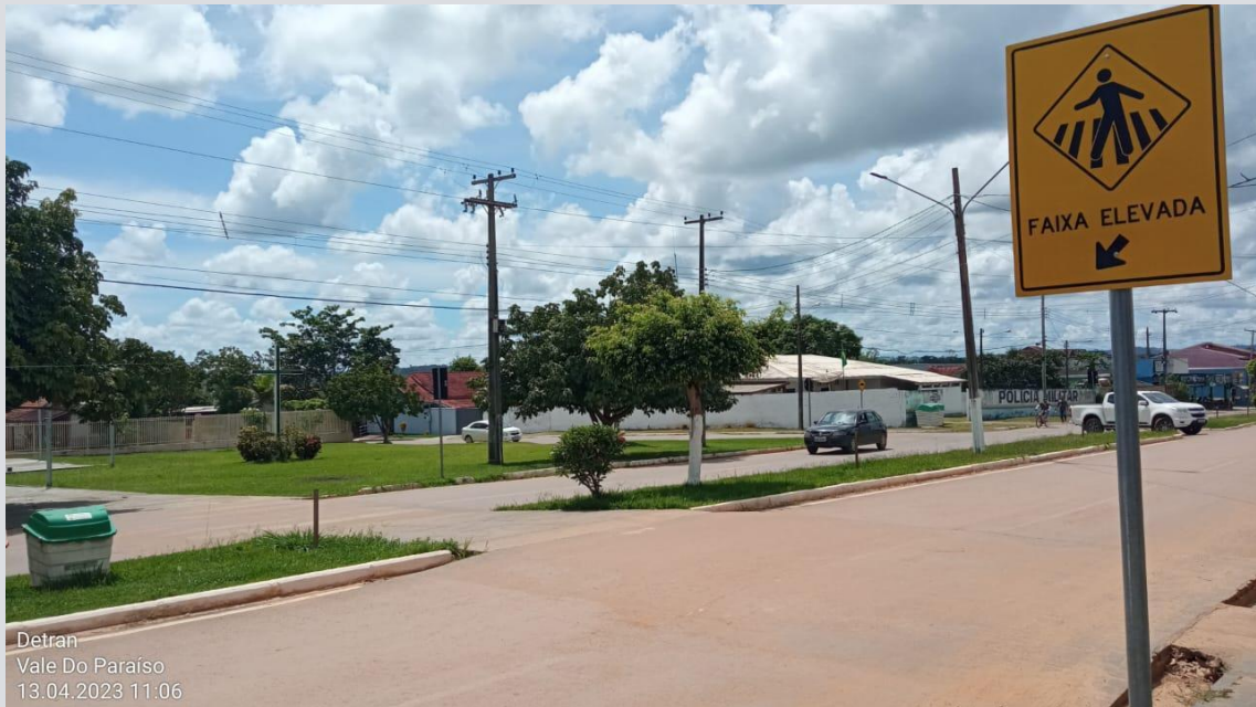
faixa elevada incompleta
