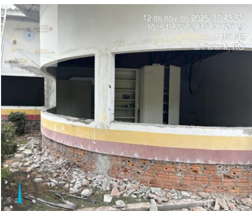
Foto 15 - DEMOLIÇÃO DE ARGAMASSAS, DE FORMA DE FORMA MECANIZADA COM MARTELETE, SEM
