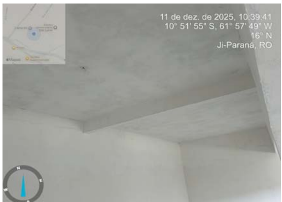
Foto 8 - FUNDO SELADOR ACRÍLICO, APLICAÇÃO MANUAL EM TETO, UMA DEMÃO. AF_04/2023
