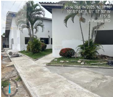
Foto 1 -EXECUÇÃO DE PASSEIO (CALÇADA) OU PISO DE CONCRETO COM CONCRETO MOLDADO IN LOCO, USINADO C25, ACABAMENTO CONVENCIONAL, NÃO ARMADO, 45. 02/2023
