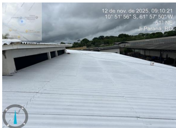
Foto 2 - IMPERMEABILIZAÇÃO DE SUPERFÍCIE COM ARGAMASSA POLIMÉRICA - PRÉDIO SEDE
