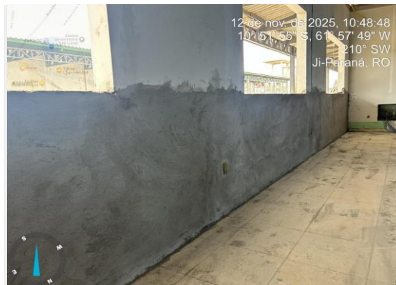
Foto 8 - IMPERMEABILIZAÇÃO DE SUPERFÍCIE COM ARGAMASSA POLIMÉRICA /
