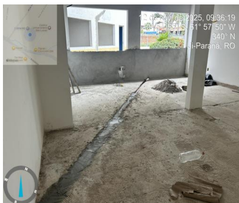
Foto 5 - RASGO LINEAR MANUAL EM ALVENARIA, PARA RAMAIS/ DISTRIBUIÇÃO DE INSTALAÇÕES ELÉTRICAS
