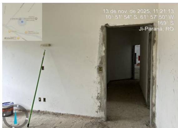
Foto 6 - REQUADRO LINEAR, EM ARGAMASSA OU MASSA PRONTA, DE PORTAS E JANELAS
