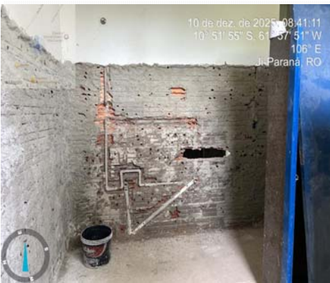
Foto 5 - DEMOLIÇÃO DE ARGAMASSAS, DE FORMA DE FORMA MECANIZADA COM MARTELETE, SEM REBAR, 45. 02/2023
