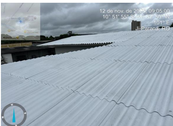
Foto 4 - IMPERMEABILIZAÇÃO DE SUPERFÍCIE COM ARGAMASSA POLIMÉRICA - PRÉDIO SEDE
