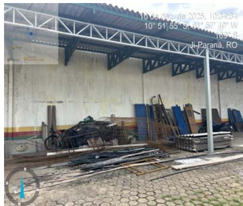
Foto 15 - RETIRADA DE ESQUADRIAS, TELHAS E DEMAIS ITENS.
