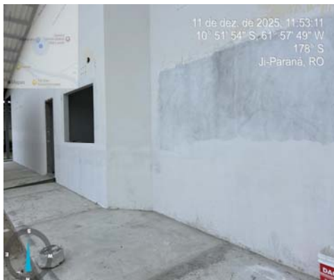
Foto 7 - FUNDO SELADOR ACRÍLICO, APLICAÇÃO MANUAL EM PAREDE, UMA DEMÃO. AF_04/2023
