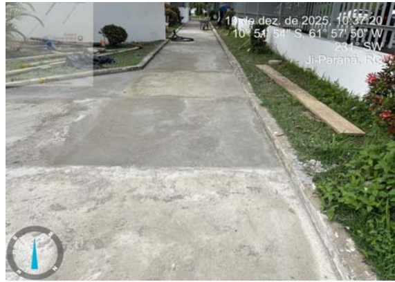
Foto 2 - EXECUÇÃO DE PASSEIO (CALÇADA) OU PISO DE CONCRETO COM CONCRETO MOLDADO IN LOCO, USINADO C25, ACABAMENTO CONVENCIONAL, NÃO ARMADO, 45. 02/2023
