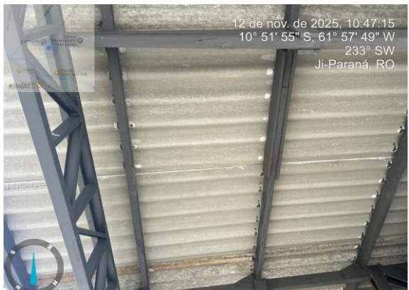
Foto 14 - PINTURA COM TINTA ALQUÍDICA DE FUNDO (TIPO ZARCÃO) APLICADA A ROLO OU PINCEL SOBRE
