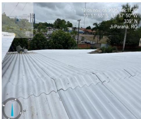
Foto 1 - IMPERMEABILIZAÇÃO DE SUPERFÍCIE COM ARGAMASSA POLIMÉRICA - PRÉDIO SEDE
