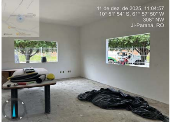
Foto 10 - EMASSAMENTO COM MASSA ACRÍLICA, APLICAÇÃO EM PAREDE, DUAS DEMÃOS, AF_04/2023
