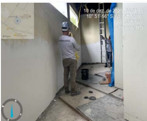
Foto 9 - EMASSAMENTO COM MASSA ACRÍLICA, APLICAÇÃO EM PAREDE, DUAS DEMÃOS, AF_04/2023
