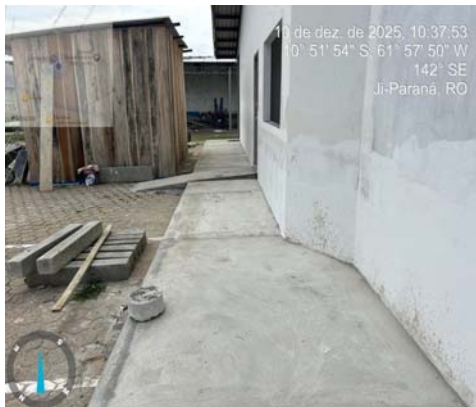
Foto 3 - EXECUÇÃO DE PASSEIO (CALÇADA) OU PISO DE CONCRETO COM CONCRETO MOLDADO IN LOCO, USINADO C25, ACABAMENTO CONVENCIONAL, NÃO ARMADO, 45. 02/2023
