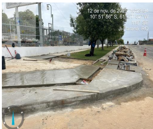
Foto 17 - EXECUÇÃO DE PASSEIO (CALÇADA) OU PISO DE CONCRETO COM CONCRETO MOLDADO IN LOCO,
