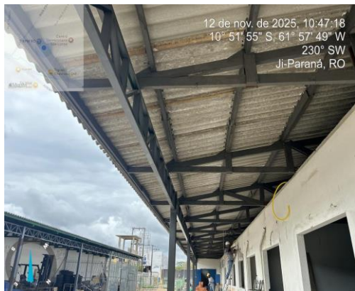
Foto 13 - PINTURA COM TINTA ALQUÍDICA DE FUNDO (TIPO ZARCÃO) APLICADA A ROLO OU PINCEL SOBRE
