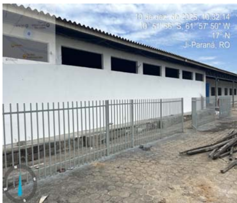
Foto 11 - PINTURA COM TINTA ALQUÍDICA DE ACABAMENTO (ESMALTE SINTÉTICO BRILHANTE) AF_04/2023
