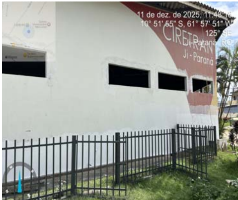
Foto 13 - EMASSAMENTO COM MASSA ACRÍLICA, APLICAÇÃO EM PAREDE, DUAS DEMÃOS, LIXAMENTO
