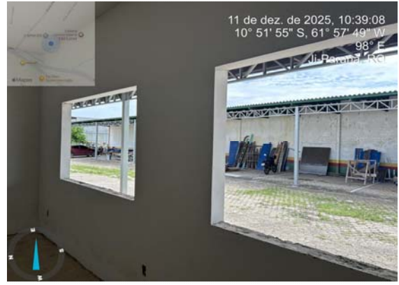
Foto 6 - REQUADRO LINEAR, EM ARGAMASSA OU MASSA PRONTA, DE PORTAS E JANELAS 45. 02/2023
