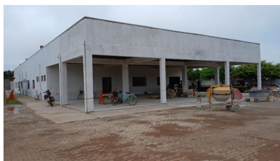
Foto 006 – Lixamento prévio e aplicação de fundo selador acrílico em paredes EXTERNO-SEDE.
