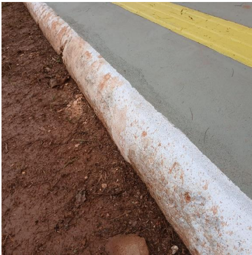
Foto 013 – Pintura de meio-fio com tinta branca a base de cal (caiação) - SEDE.
