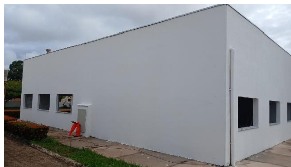
Foto 004 – Textura acrílica, aplicação manual em parede externa.
