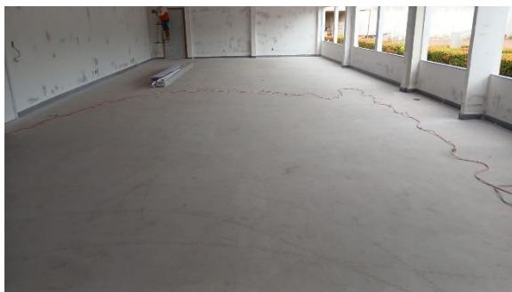
Foto 001 – Execução de rodapé, h = 10 cm.
