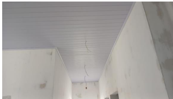
Foto 006 – Forro em réguas de PCV frisado, com estrutura metálica de fixação e acabamento roda-teto - EXISTENTE.
