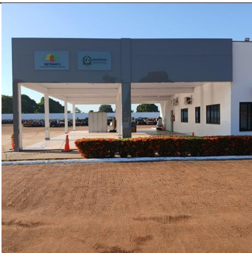
Foto 005 – Fornecimento e Instalação de fachada revestido com ACM (alumínio + polietileno + alumínio), tipo bandeja e = 21mm, fixado com rebite galvanizado em estrutura metálica de metalon 20 x 20 mm chapa 20. Conforme Projeto - SEDE.
