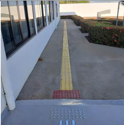
Foto 011 – Pintura de piso com tinta acrílica, aplicação manual, 2 demãos - SEDE.
