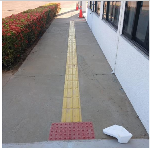
Foto 012 – Fornecimento e instalação de piso tátil direcional/alerta em ladrilho hidráulico, 25x25cm - área externa - SEDE.
