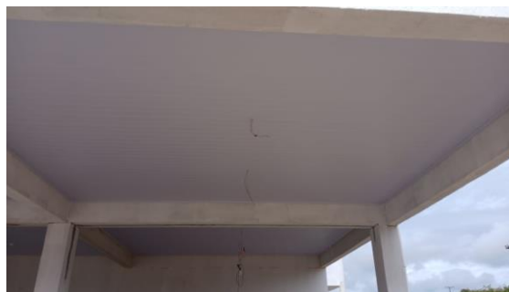
Foto 002 – Forro em réguas de PCV frisado, com estrutura metálica de fixação e acabamento roda-teto - AMPLIAÇÃO.
