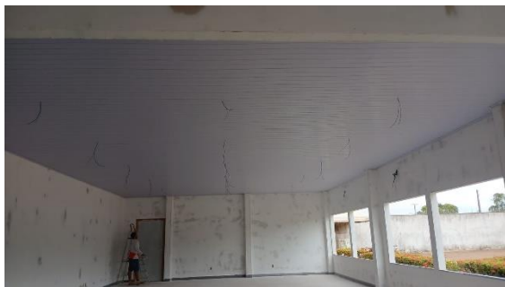
Foto 003 – Forro em réguas de PCV frisado, com estrutura metálica de fixação e acabamento roda-teto - EXISTENTE.
