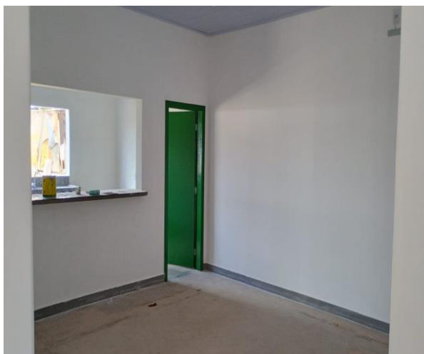
Foto 007 – Aplicação manual de pintura com tinta látex acrílica em paredes, duas demãos. INTERNO-SEDE.
