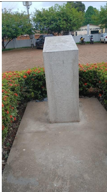
Foto 008 – Estrutura em concreto armado – BASE PLACA DE INAUGURAÇÃO.
