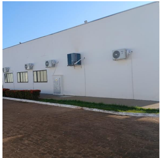
Foto 014 – Pintura de meio-fio com tinta branca a base de cal (caiação) - SEDE.
