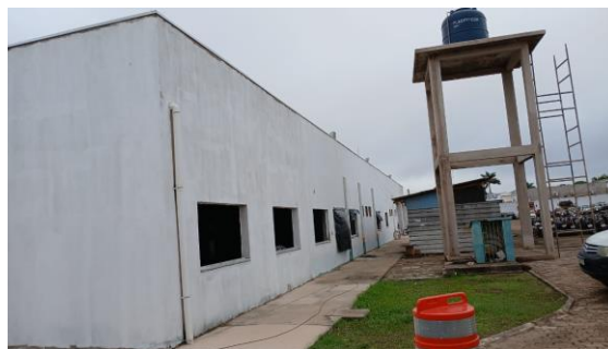
Foto 008 – Lixamento prévio e aplicação de fundo selador acrílico em paredes EXTERNO-SEDE.
