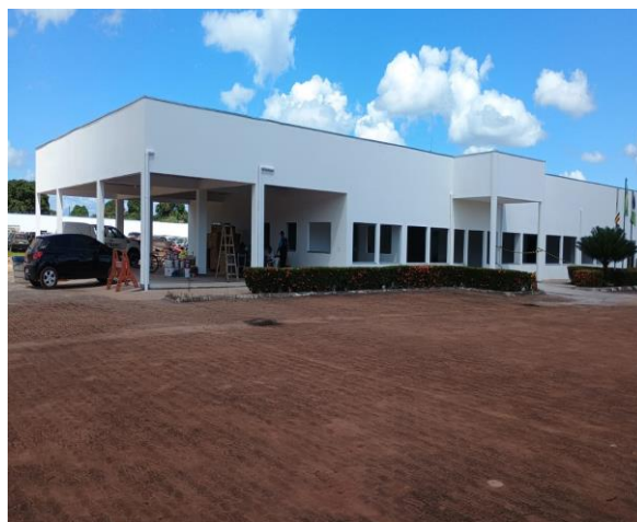
Foto 008 – Textura acrílica, aplicação manual em parede, uma demão. EXTERNO-SEDE.
