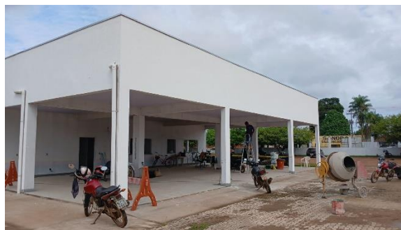
Foto 006 – Textura acrílica, aplicação manual em parede externa.
