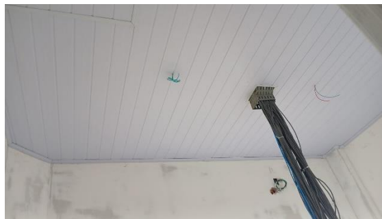
Foto 004 – Forro em réguas de PCV frisado, com estrutura metálica de fixação e acabamento roda-teto - EXISTENTE.
