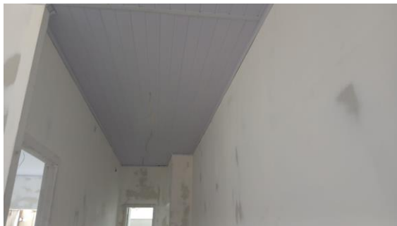
Foto 005 – Forro em réguas de PCV frisado, com estrutura metálica de fixação e acabamento roda-teto - EXISTENTE.
