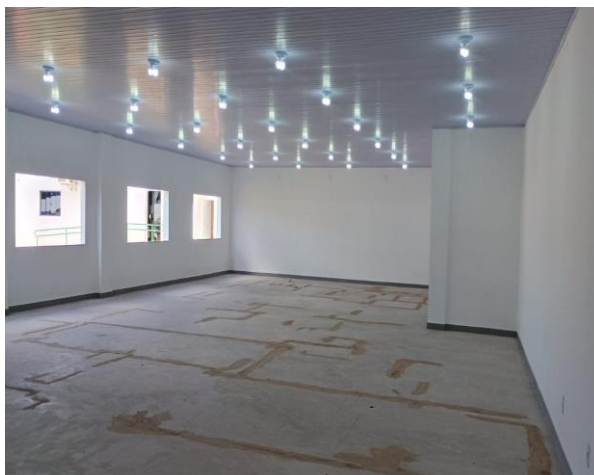
Foto 005 – Aplicação manual de pintura com tinta látex acrílica em paredes, duas demãos. INTERNO-SEDE.
