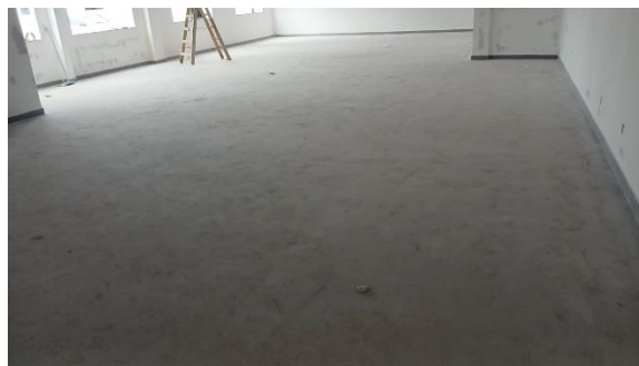
Foto 002 – Execução de rodapé, h = 10 cm.
