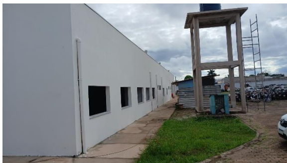
Foto 005 – Textura acrílica, aplicação manual em parede externa.
