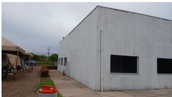
Foto 007 – Lixamento prévio e aplicação de fundo selador acrílico em paredes EXTERNO-SEDE.
