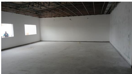
Foto 003 – Lixamento prévio, aplicação de fundo selador e aplicação e lixamento de massa látex para execução de pintura INTERNO-SEDE.
