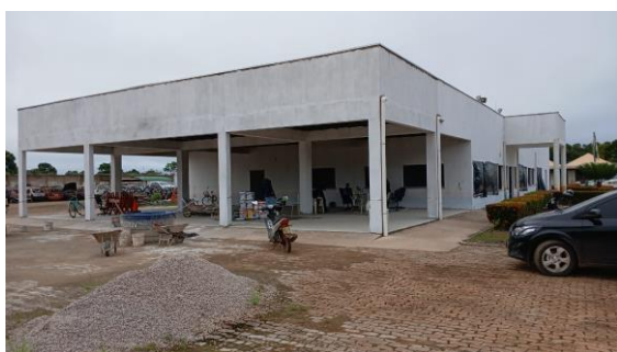
Foto 005 – Lixamento prévio e aplicação de fundo selador acrílico em paredes EXTERNO-SEDE.
