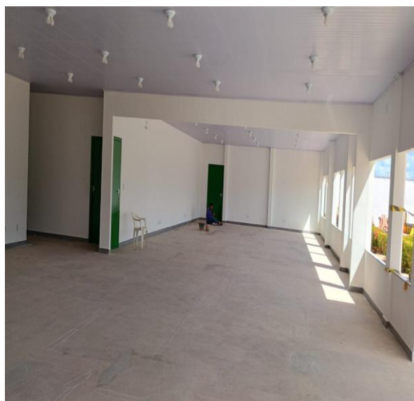
Foto 004 - Aplicação manual de pintura com tinta látex acrílica em paredes, duas demãos. INTERNO-SEDE
