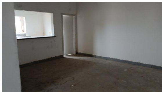
Foto 004 – Lixamento prévio, aplicação de fundo selador e aplicação e lixamento de massa látex para execução de pintura INTERNO-SEDE.
