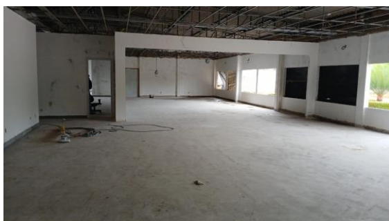
Foto 001 – Lixamento prévio, aplicação de fundo selador e aplicação e lixamento de massa látex para execução de pintura INTERNO-SEDE.
