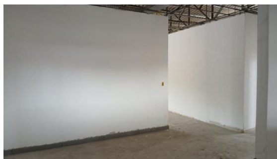
Foto 002 – Lixamento prévio, aplicação de fundo selador e aplicação e lixamento de massa látex para execução de pintura INTERNO-SEDE.
