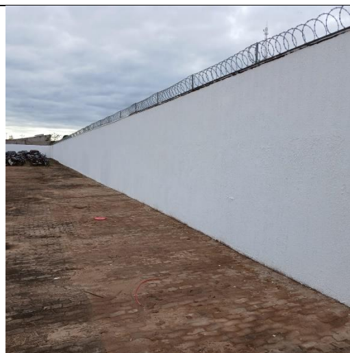
Foto 018 – Textura acrílica, aplicação manual em parede, uma demão - MURO.
