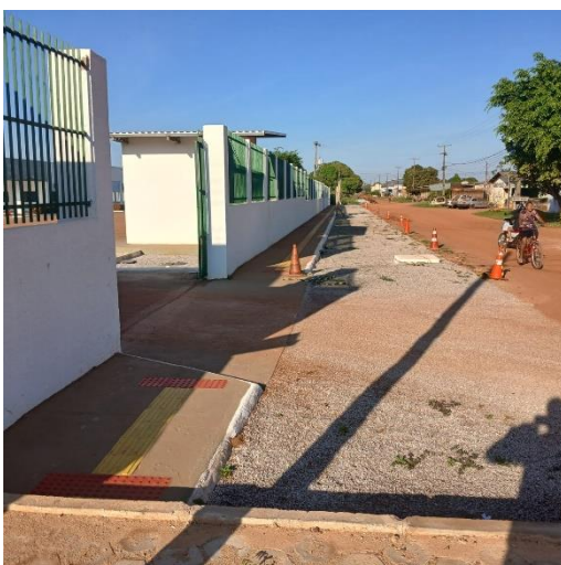
Foto 009 – Camada de brita - SEDE.
