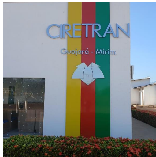
Foto 006 – Fornecimento e Instalação de fachada revestido com ACM (alumínio + polietileno + alumínio), tipo bandeja e = 21mm, fixado com rebite galvanizado em estrutura metálica de metalon 20 x 20 mm chapa 20. Conforme Projeto - SEDE.
