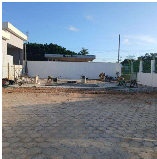
Foto 002 – Execução de pátio/estacionamento em piso intertravado
