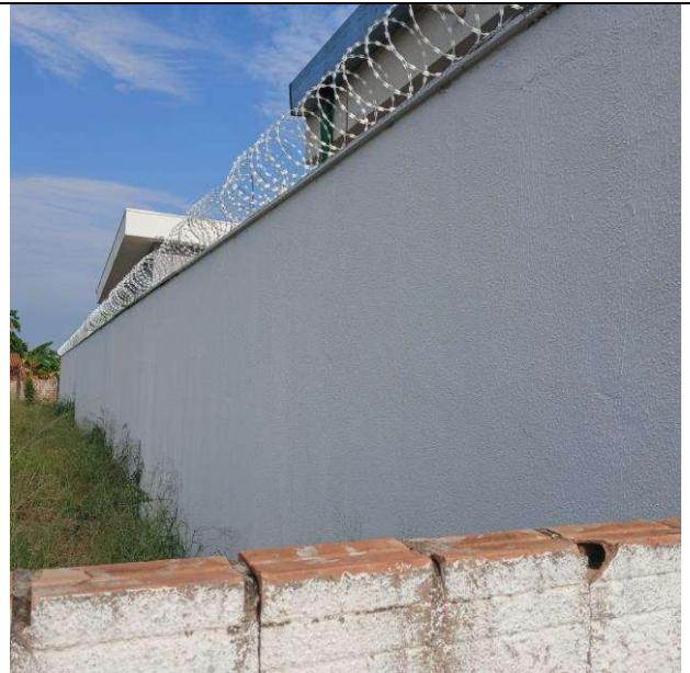
Foto 004 – Textura acrílica, aplicação manual uma demão e concertina.
