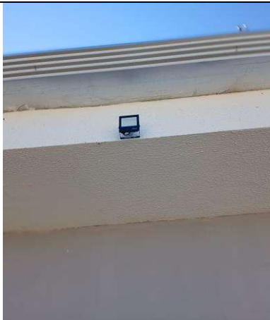
Foto 005 – Luminária led refletor retangular bivolt, luz branca, 50W. - EXTERNO
