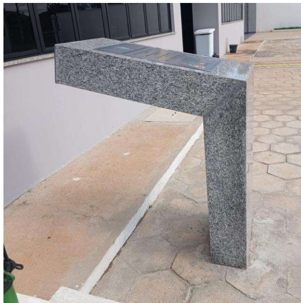
Foto 010 – Suporte da placa revestido em granito.
