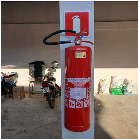
Foto 007 – Fornecimento e instalação de extintor.
