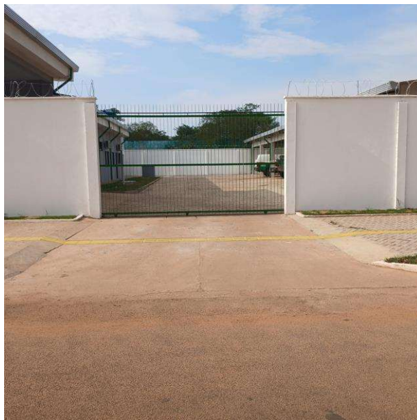
Foto 013 – Piso de concreto com concreto moldado in loco, feito em obra, acabamento convencional, espessura 8 cm, armado.
