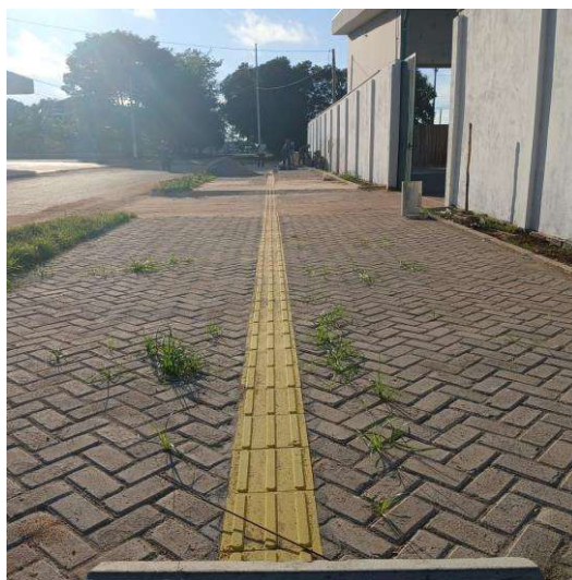
Foto 004 – Execução de passeio em piso intertravado.
