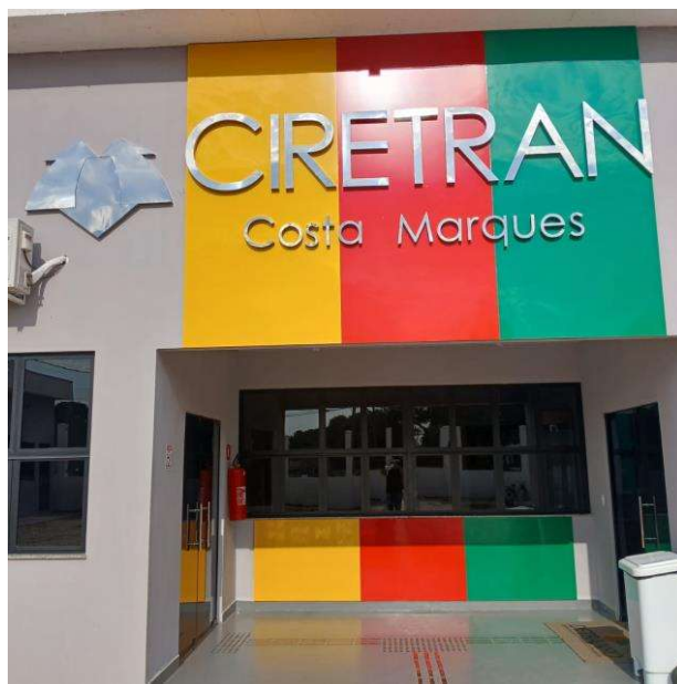
Foto 002 – Conjunto de letreiro em aço INOX brilhante e Fachada revestido com ACM.
