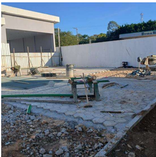
Foto 001 – Limpeza, escavação, execução e compactação de aterro.
