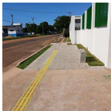
Foto 010 – Plantio de grama e execução de passeio (calçada).
