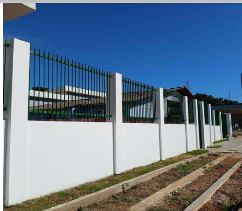
Foto 002 – Pintura dos muros
