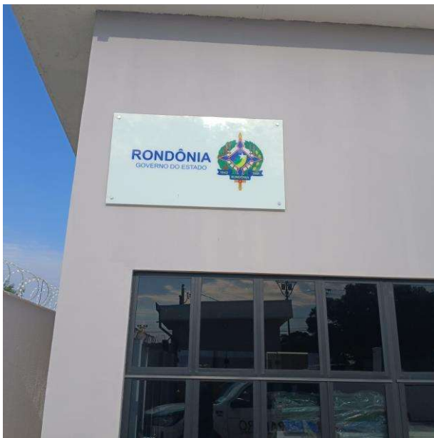
Foto 005 – Fornecimento e instalação de placa de vidro laminado 8mm, com impressão de adesivo vinil, medindo (0,85*1,50).
