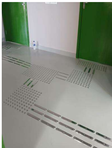
Foto 003 – Instalação de piso tátil “direcional”
