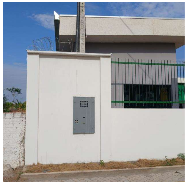
Foto 006 – Fornecimento e instalação de pingadeira de concreto pré-moldado para muro e concertina.
