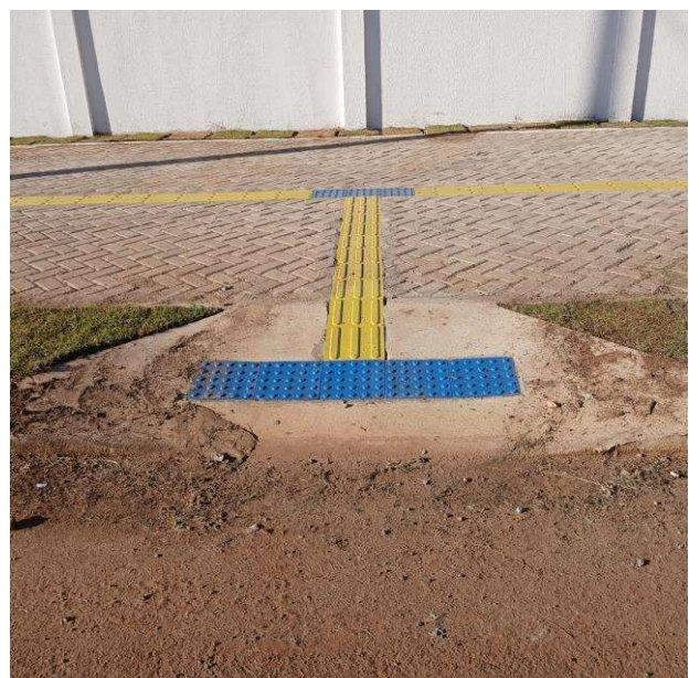
Foto 014 – Piso de concreto com concreto moldado in loco, feito em obra, acabamento convencional, espessura 8 cm, armado.
