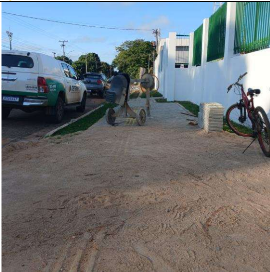
Foto 005 – Execução de passeio e guia (meio-fio). EXTERNO
