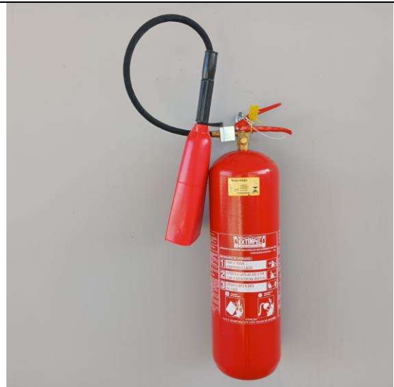
Foto 006 – Fornecimento e instalação de extintor.
