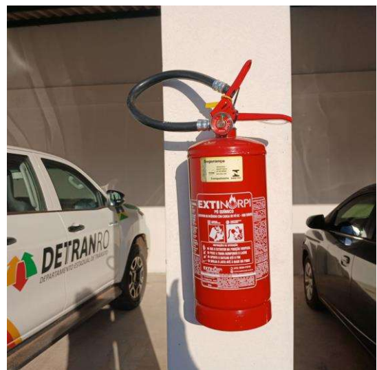
Foto 008 – Fornecimento e instalação de extintor.
