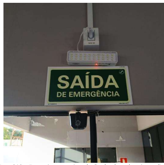
Foto 010 – Fornecimento e instalação de placa de orientação e salvamento.
