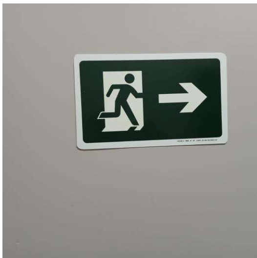
Foto 009 – Fornecimento e instalação de placa de orientação e salvamento.
