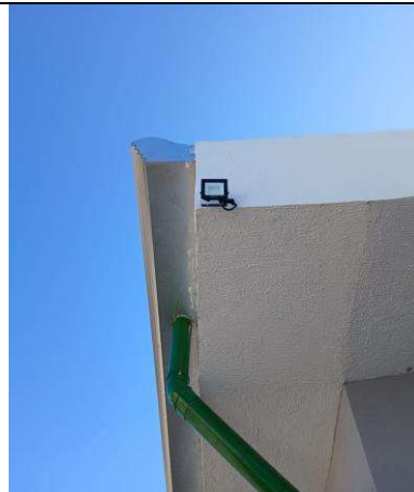
Foto 006 – Luminária led refletor retangular bivolt, luz branca, 50W. - EXTERNO
